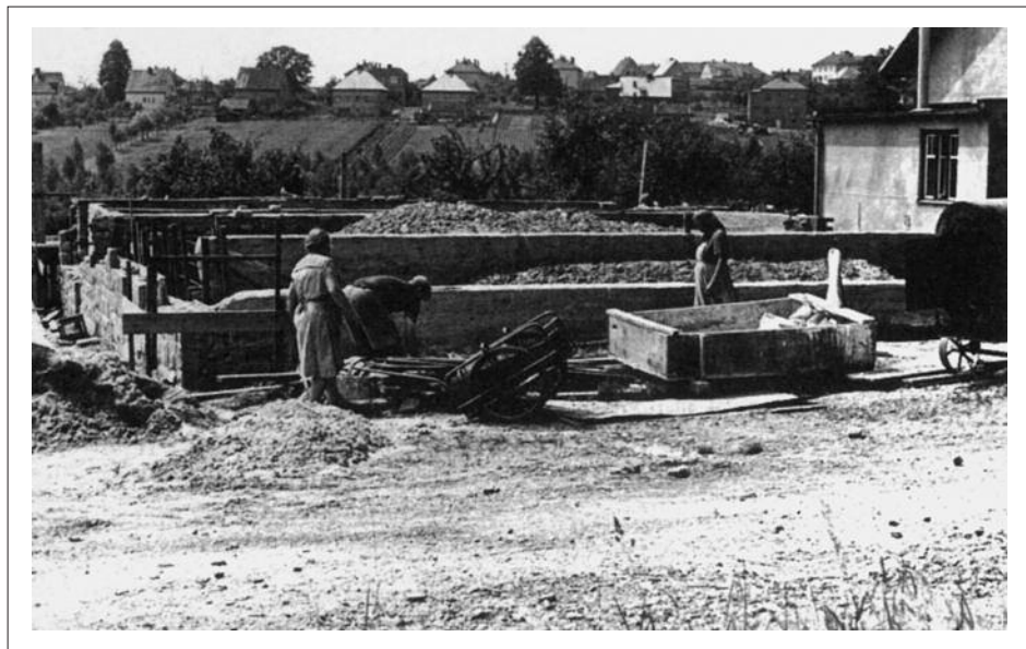
Základy pod kostel
